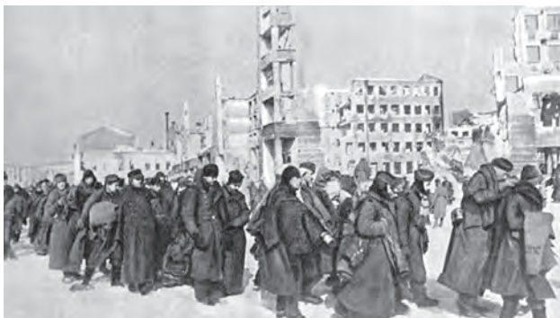
▲ Колонна немцев, взятых в плен под Сталинградом
