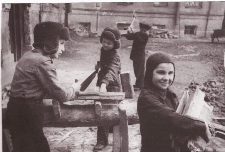
Ребята-тимуровцы за работой. [1941–1944 гг.], Ленинград. Фото Д. Трахтенберга
